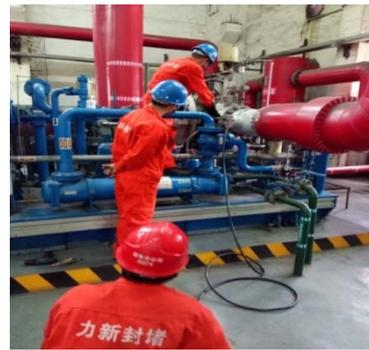
图 7 均匀安装螺栓
