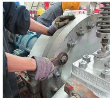
图 8 用高压堵漏材料进行封堵
