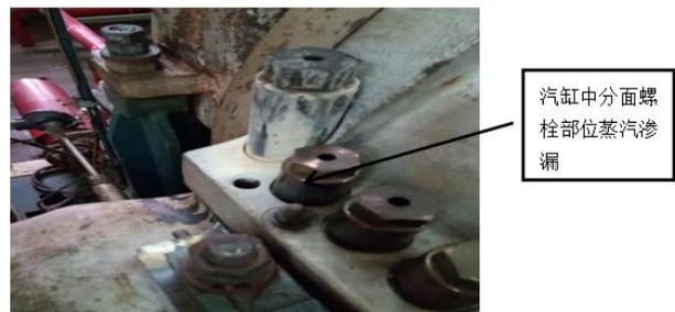
图 3 汽缸中分面螺栓部位渗漏
