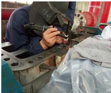
图 5 汽缸中分面局部补焊
