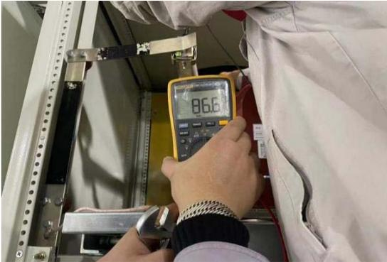
图7 更换后 31PT A 相熔断器的电阻值
