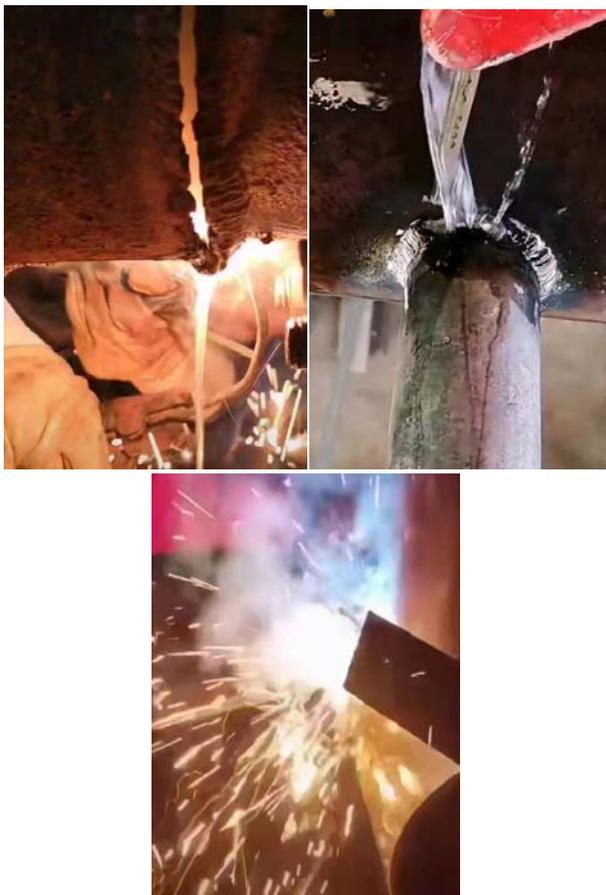
图 3 带水带压固定焊接
