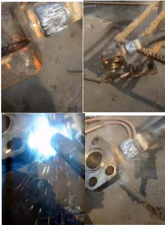
图1 带水手工电弧焊
