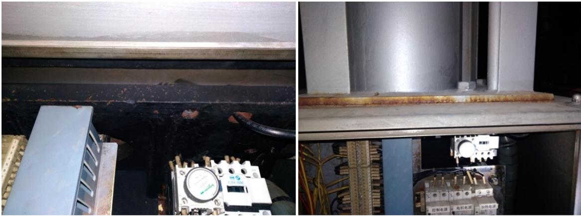
图 3 操作机构箱密封及锈蚀状况
