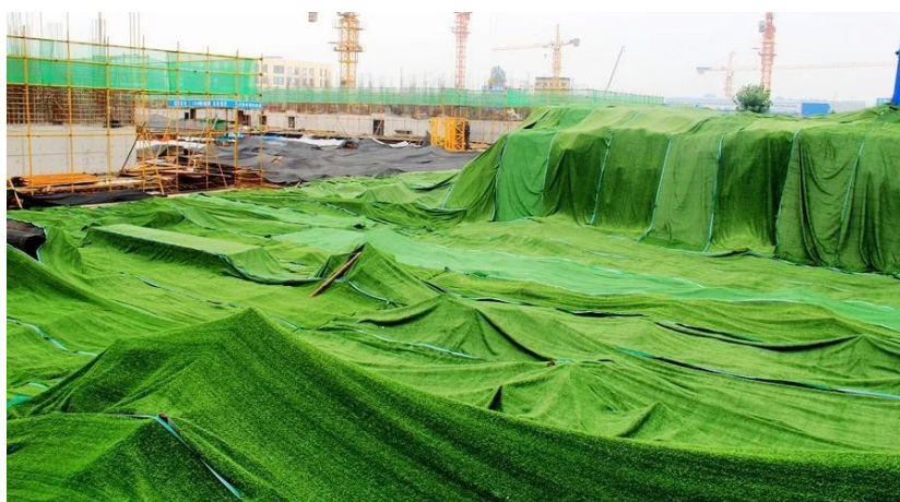
图2 易飞扬材料覆盖处理
