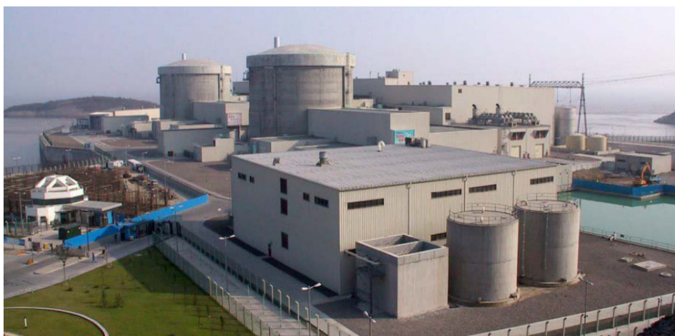
图 2 核电建设项目施工现场全貌
