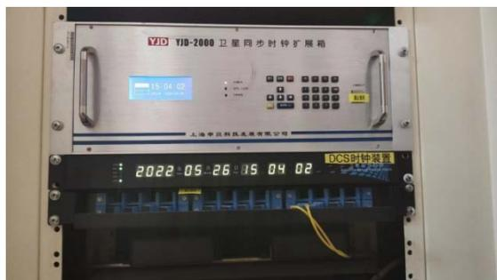
图 2 国电电力大同发电公司 9、10 号机组 DCS 系统采用的 NTP 网络对时方式
