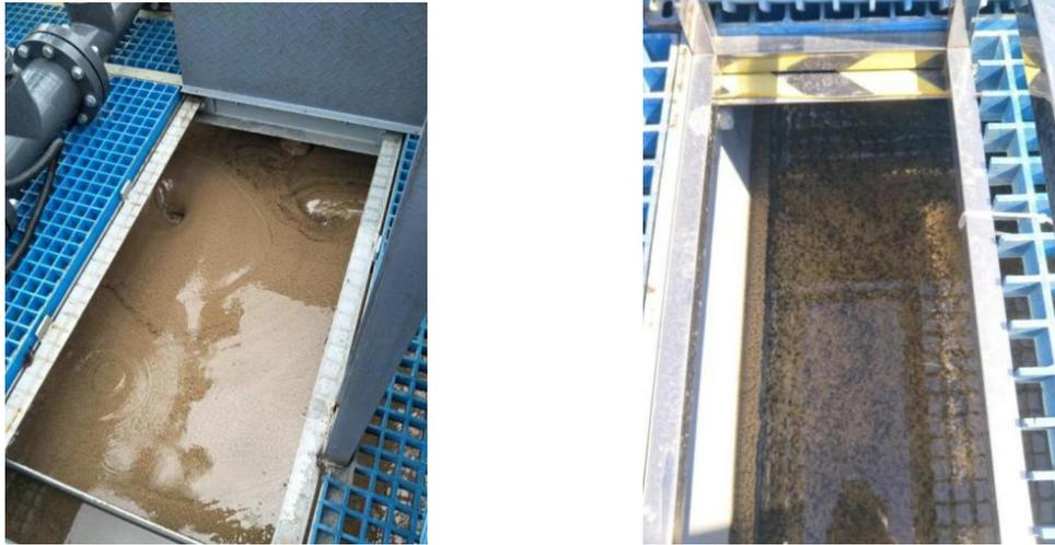
图 6 絮凝池絮凝效果对比图 (左: 絮凝效果差; 右: 絮凝效果良好)
